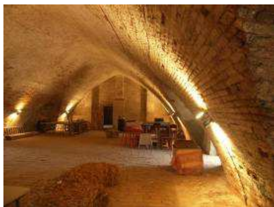
Obr.4 Čiastočne zrekonštruovaná veľká sála vzdelávacieho strediska
