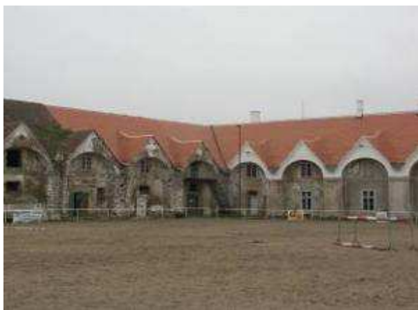
Obr.1 Zrekonštruovaná časť žrebčína, kde bude umiestnené vzdelávacie stredisko
